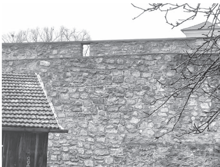
Městské opevnění po obnově
