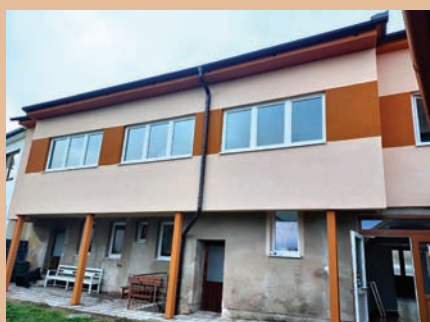
Rekonstruovaná pavlač na Kobližné 125
