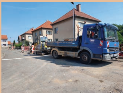
Bezvýkopová výměna vodovodu v ulici Zadní zahajuje rozsáhlou rekonstrukci
