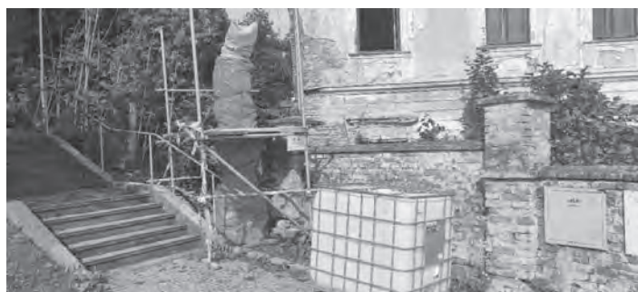
Za přispění dotace Pardubického kraje bylo zahájeno restaurování sochy sv. Floriana
