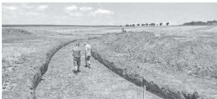
„Obec Biskupice – protipovodňová opatření – SO 01 Boční nádrž - kontrolní den na stavbě - základ budoucí hráze
