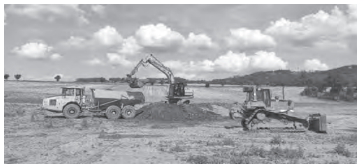
„Obec Biskupice – protipovodňová opatření – SO 01 Boční nádrž - průběh prací
