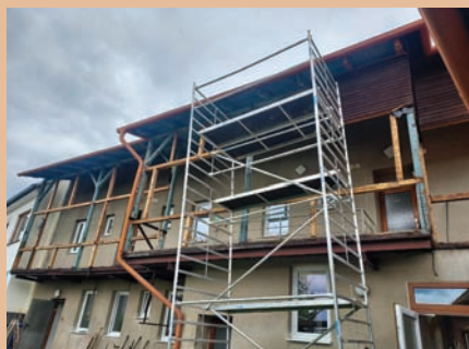
Zahájili jsme rekonstrukci pavlače v DPS Koblišná
