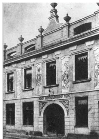
Fotografie průčelí Katolického domu se sgrafity po rekonstrukci v roce 1913
