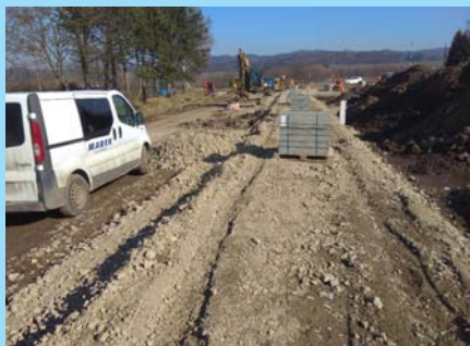
Pokračující výstavba infrastruktury průmyslové zóny
