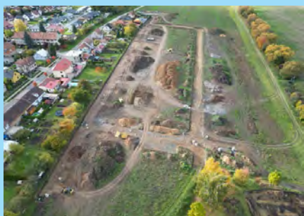
Pokračuje výstavba inženýrských sítí U Kapličky
