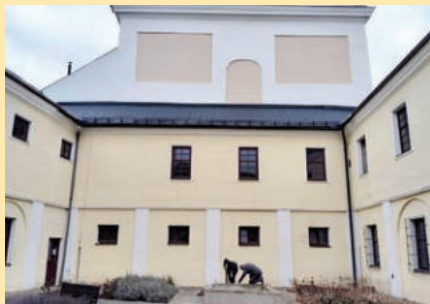
S přispěním Pardubického kraje je opravena další část střechy kláštera
