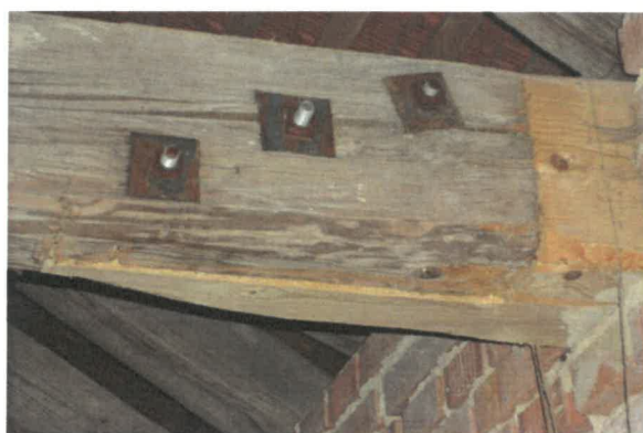
opravené zhlaví 3.NP
