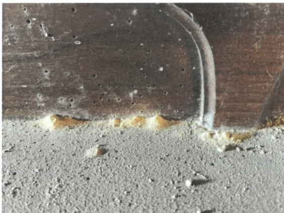
Deradace způsobená dřevokazným hmyzem
