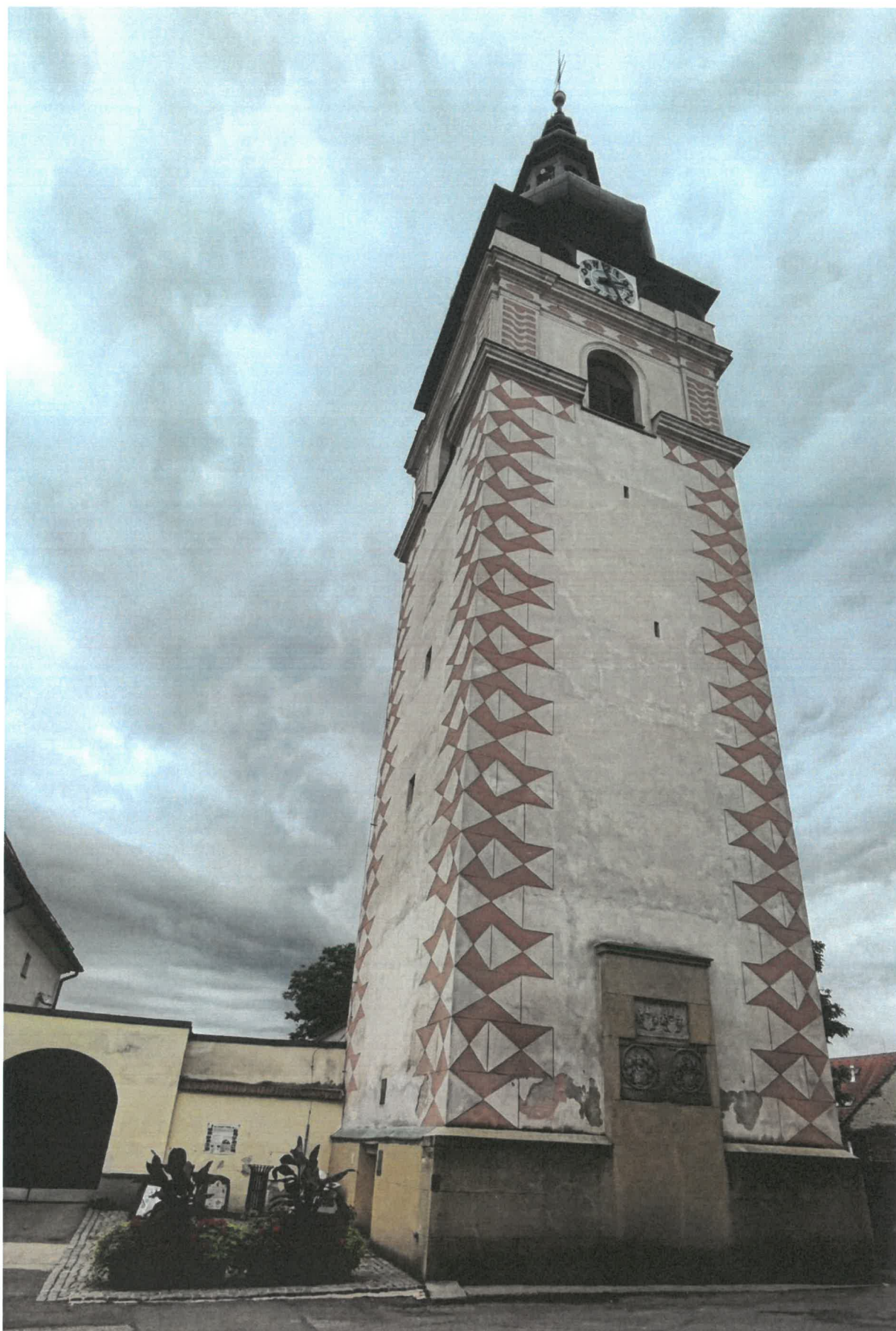
Městská věž, Komenského náměstí (obnova venkovního pláště, restaur. práce sgrafita – psaníčka)
