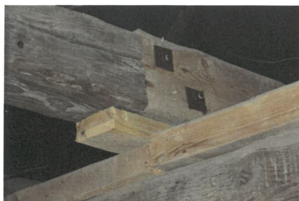
provedené opravy 3.NP
