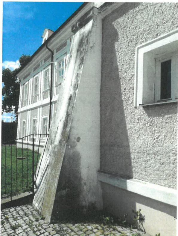
Pilíře věže zámku před a po obnově v r. 2019:
