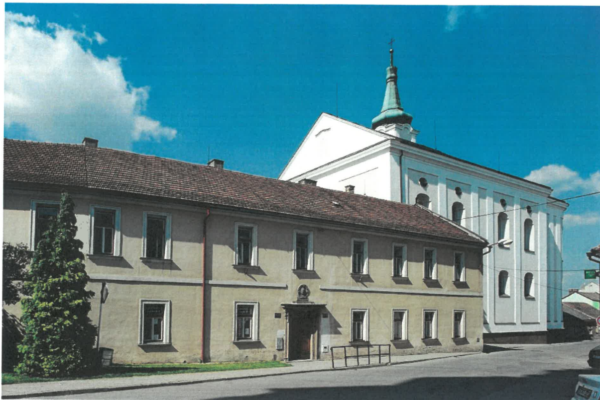
Konvent bývalého augustiniánského kláštera před a po realizaci akcí obnovy:
