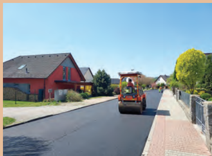
Oprava místní komunikace na ulici Slunečné
