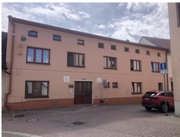
Obrázek 18: Budova objektu – DPS Kobližná, č.p. 125
