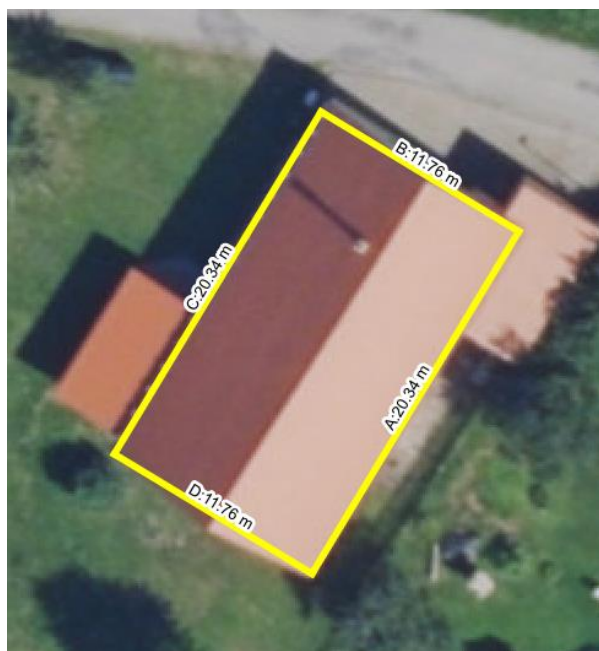
Obrázek 51: Okótovaná střecha objektu – KD Zadní Arnoštov, parc. č. st. 162
