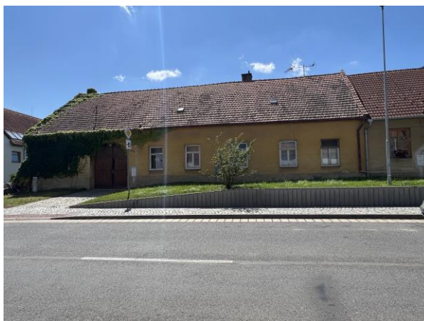
Obrázek 43: Budova objektu – RD Svitavská, č.p. 468
