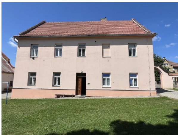
Obrázek 30: Budova objektu – BD K. H. Borovského, č.p. 465
