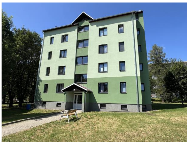
Obrázek 28: Budova objektu – BD K. Čapka, č.p. 783
