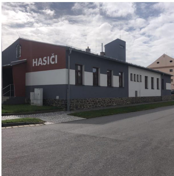
Obrázek 12: Budova objektu – Hasičská zbrojnice Jevíčko, č.p. 466
