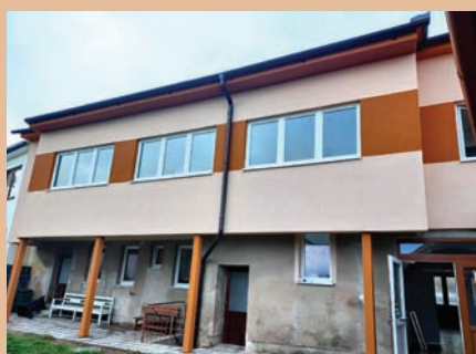
Rekonstruovaná pavlač na Kobližné 125
