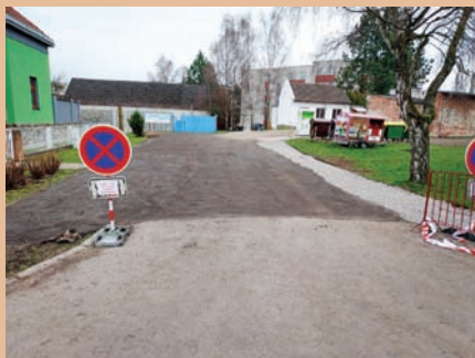
Oprava příjezdové komunikace v ulici Na Salajce
