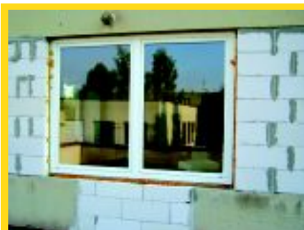
Výměna oken v areálu MŠ
