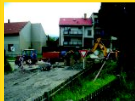
Rekonstrukce vodovodu a kanalizace Okružní II dokončena
